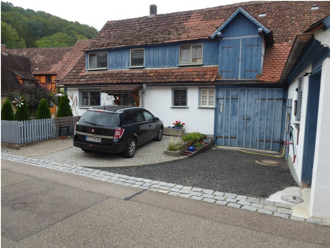
Ansicht von der Straße mit Hof- und Scheuneneinfahrt
