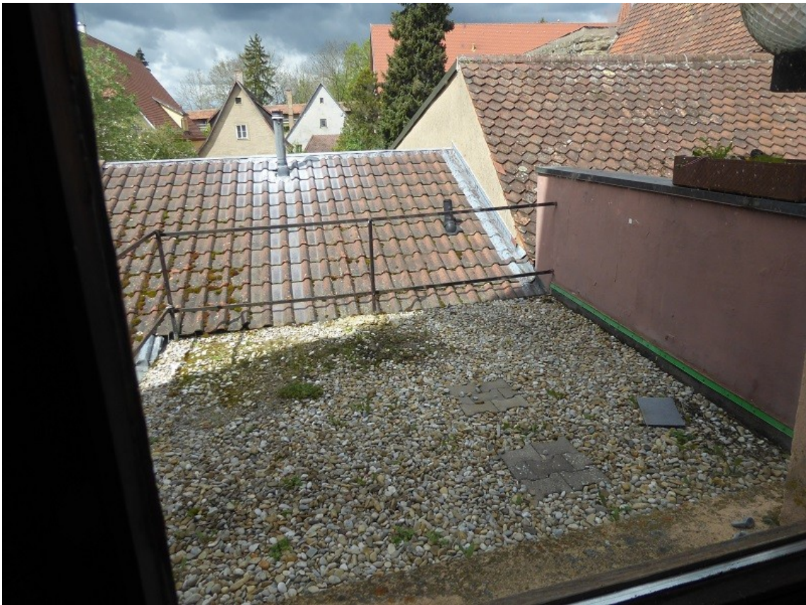
Dachterrasse im 1.Stock
